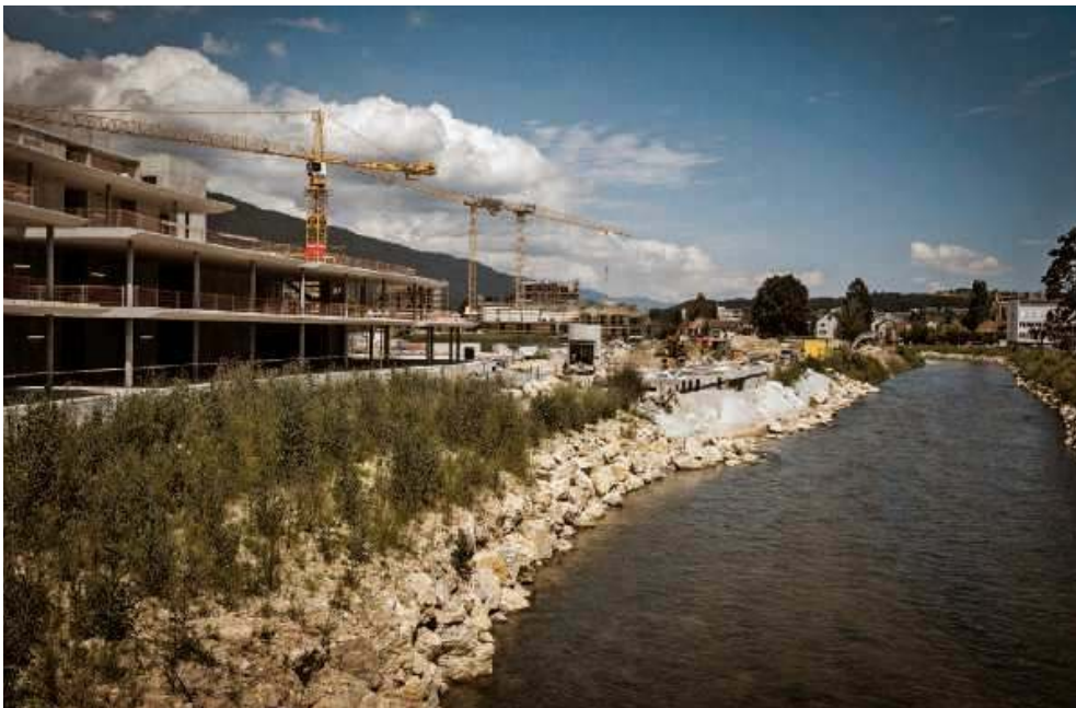
Rohbau des neuen Swatch-Hauptsitzes im Gebiet Gurzelen-Schüssinsel: Bis Sommer 2017 entsteht hier eine grüne Oase für die Bevölkerung
